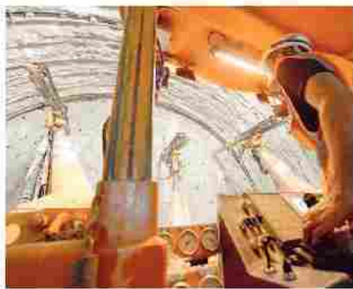
I lavori All'opera nel cantiere del Terzo valico tra Liguria e Piemonte
